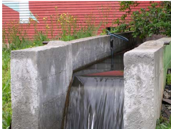
Fotografía 11-2.-Canal de vertido del Pozo San Jorge
