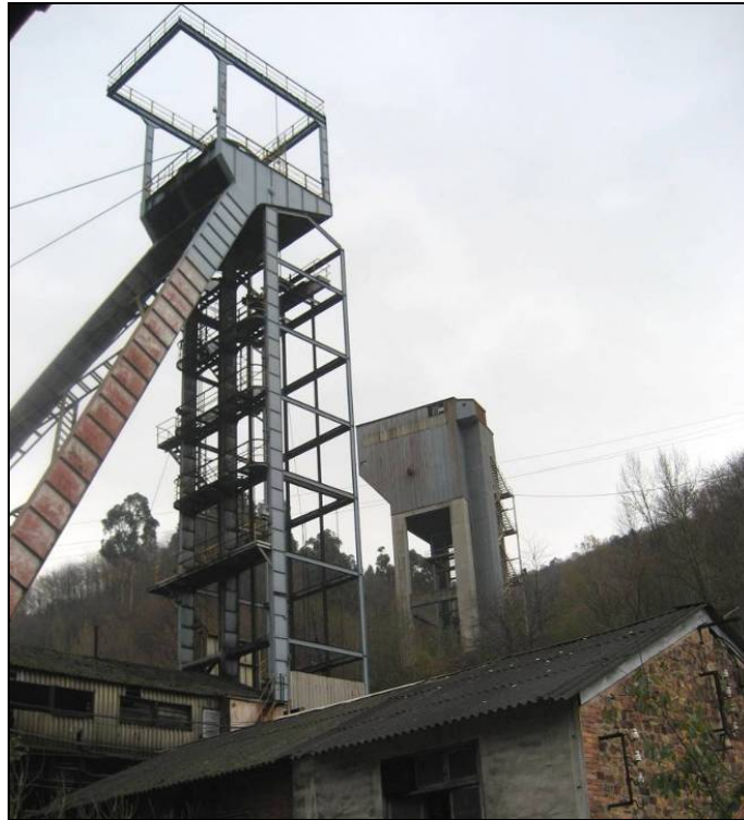
Fotografía 6-2.- Vista del Pozo Figaredo
