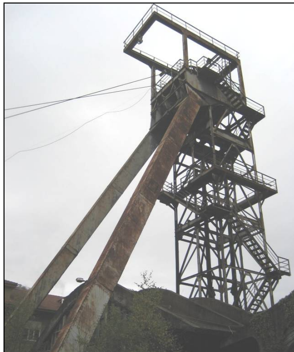
Fotografía 6-3.- Vista del Pozo San José
