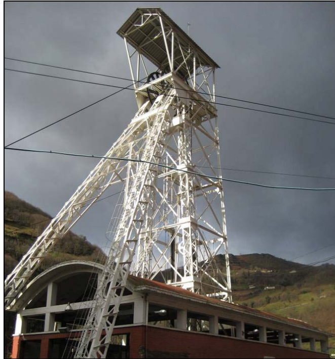
Fotografía 6-6.- Vista del Pozo San Jorge.
