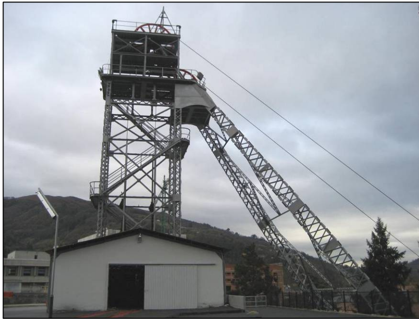
Fotografía 6-1.- Vista del Pozo Barredo
